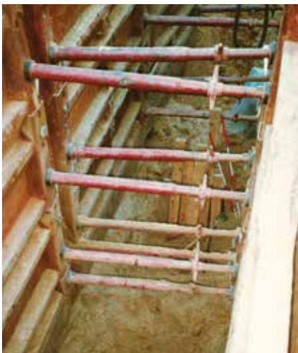
Aufgeschüttetes Gelände, breite Gräben zur Stabilisierung kann eine zusätzli- che Queraussteifung mit 2 Spann- ketten je Pfostenlage erforderlich sein. Die Spannkette liegen in der Ebene der Streben und schränken den Arbeitsraum nicht ein.
