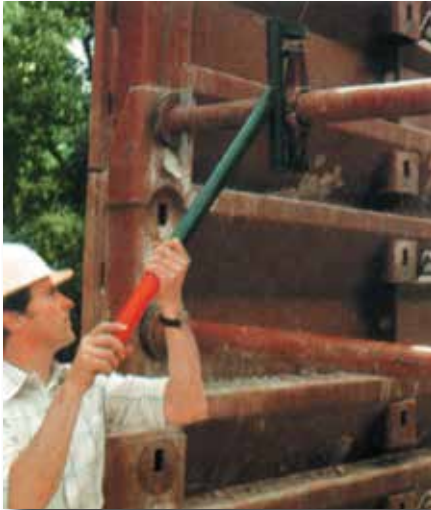
Spannen und Lösen der Streben erleichtert der Spindelschlüssel
