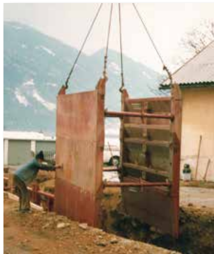
Umhüllungsbeton für die Rohrleitung Die Schneidenplatte mit glatter Innenwand dient als Schalung. Sie kann nach dem Betonieren gezogen werden.
