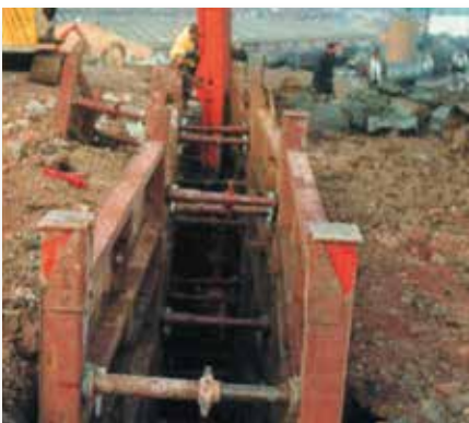
Bei großen Grabentiefen abgestufter Verbau, oben 4 m Verbauplatten, unten 3 m Verbauplatten.
