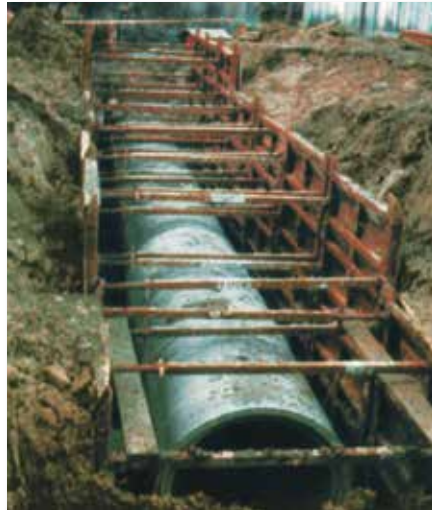
Verlegung von Großrohren auf einer Betonsohle, die den Verbau abstützt. In diesem Fall ist eine Hakenschraube im untersten Plattenstoß erforderlich.
